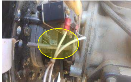
מיקום לא נכון של זרוע הבטא - קצה הזרוע מונחת מעל לפין המגביל (אמורה להיות מתחתיו)
